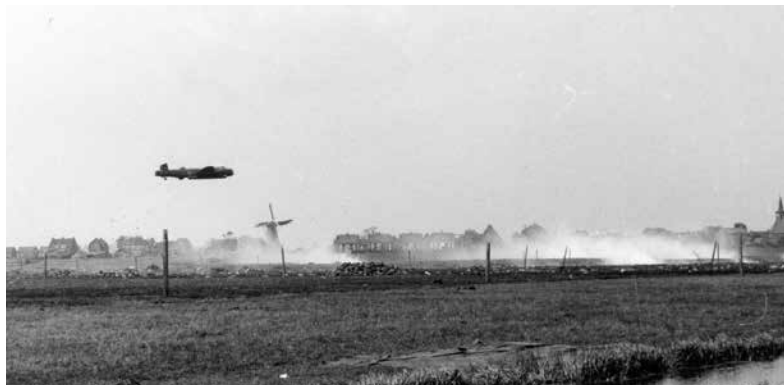
Een Britse Lancaster vliegt op geringe hoogte over de weiden die nu Nieuw-Terbegge vormen. Op de achtergrond zijn de gebouwen aan de Rotte duidelijk herkenbaar (Foto© Hans Onderwater)
